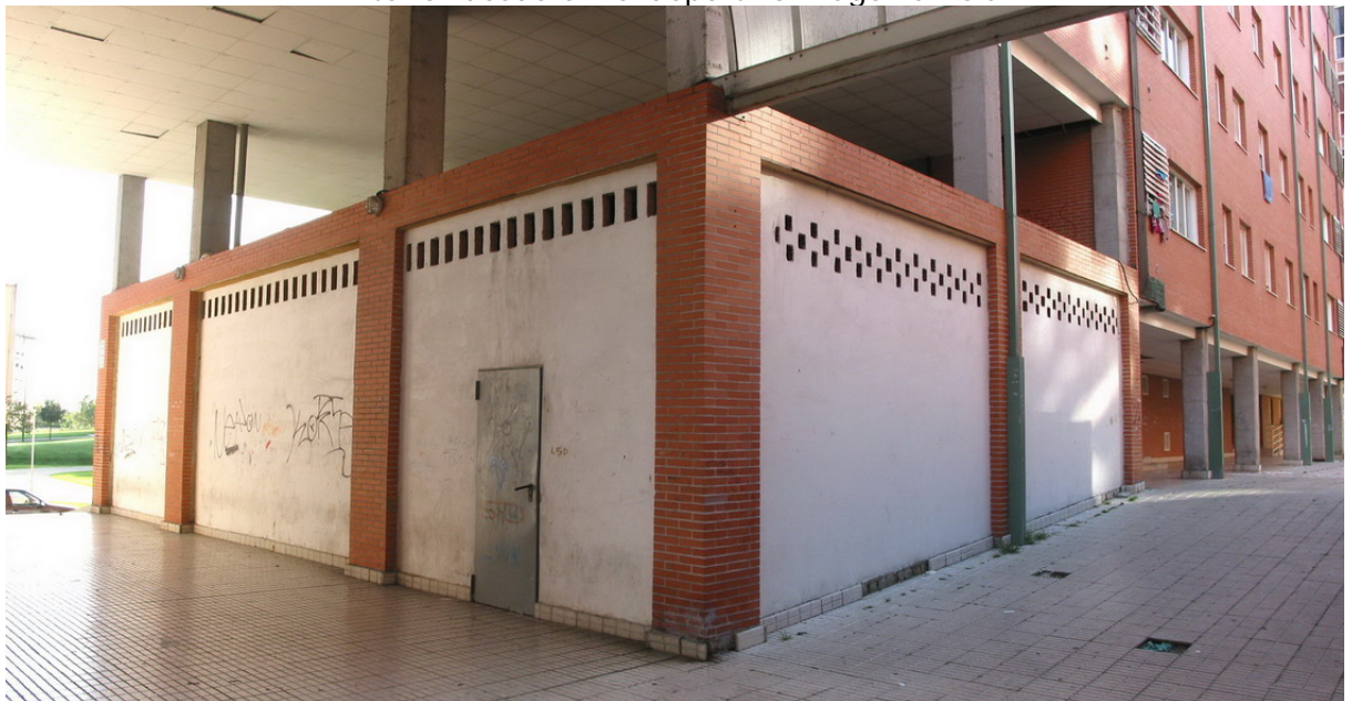
Exterior del local desde los espacios interiores.
