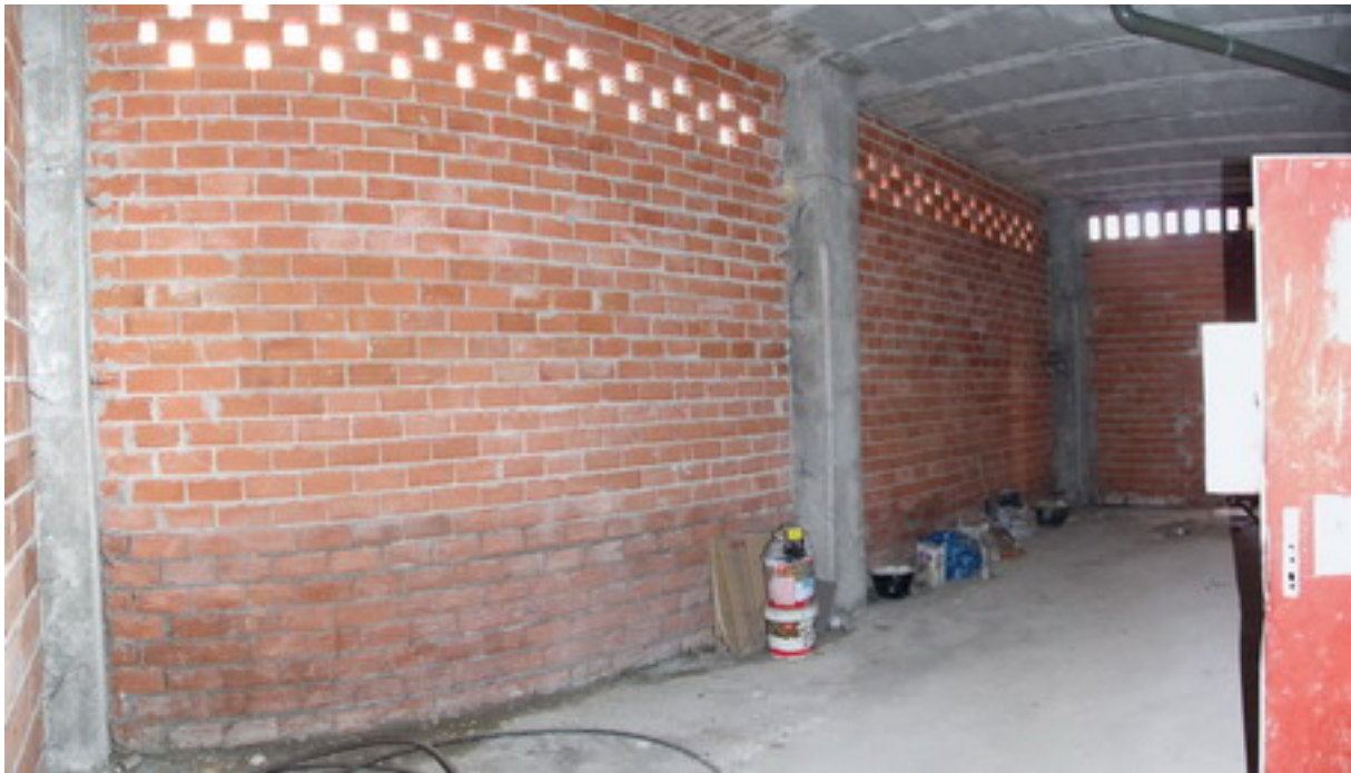
Interior del local hacia la entrada.
